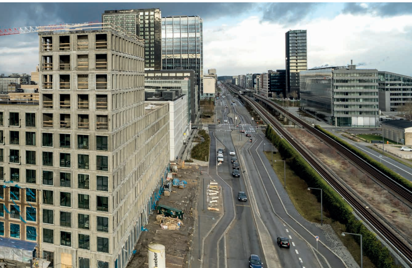
Byggeriet af Kanalgaarden, december 2023.
